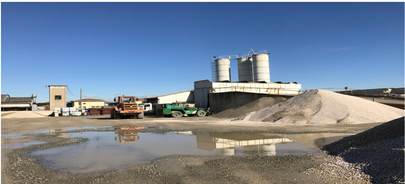
Figura 1 GIULIANI PIERO SRL IMPIANTO PRODUZIONE CALCESTRUZZI BIENTINA
